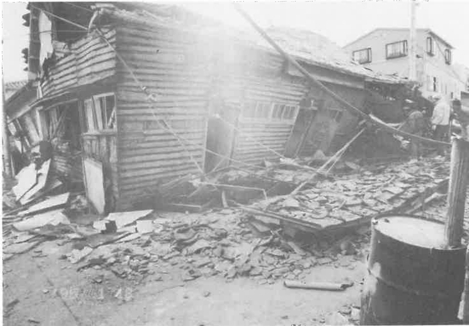
エルマーとロドルフの住んでいた倒壊したアパート
